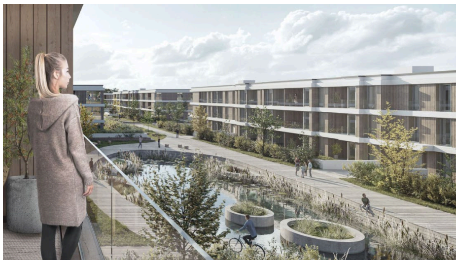
Rezidence Na Mariánské cestě, Brandýs nad Labem
