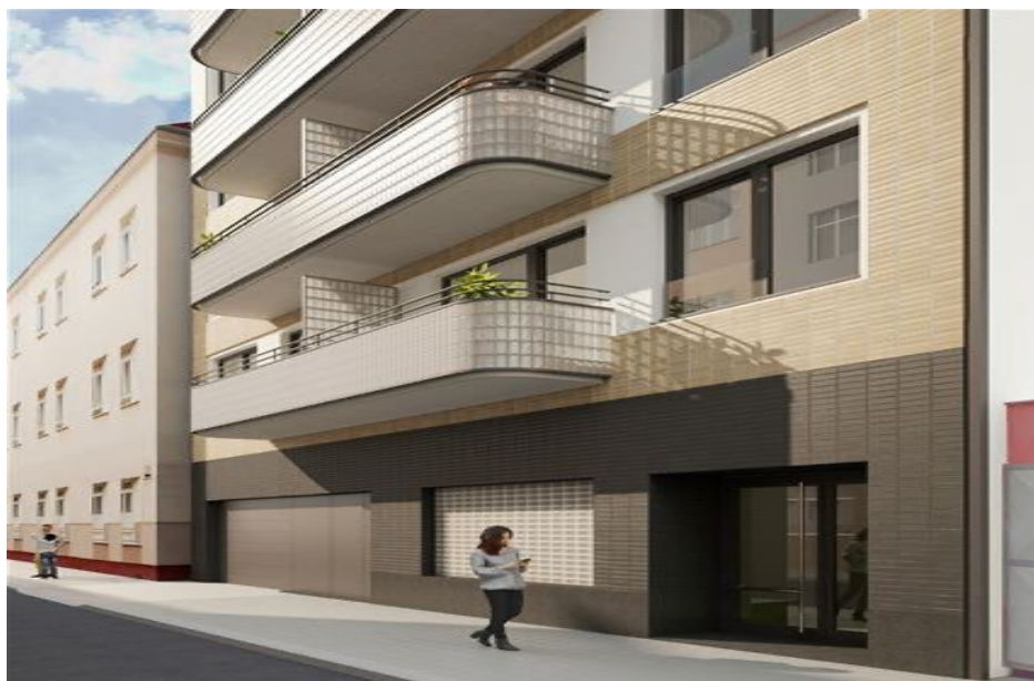
Bytový dům Příční 14/Příční Brno
